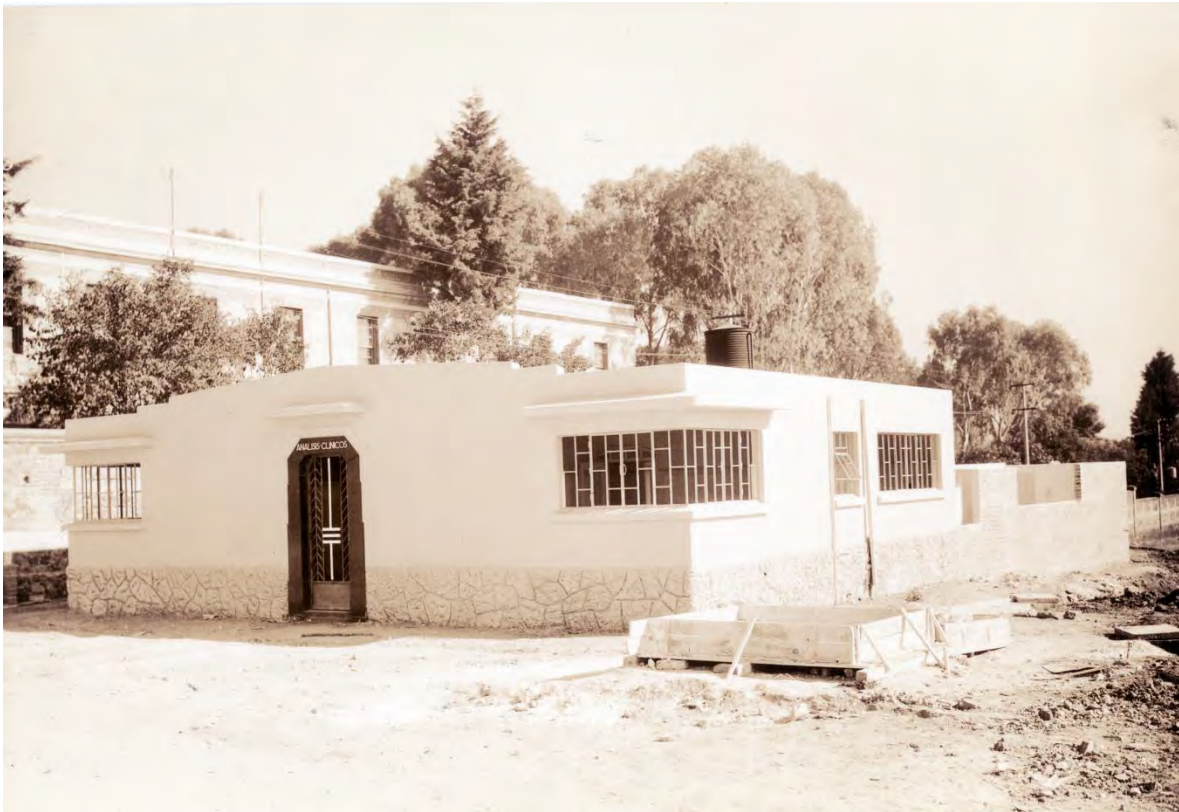
Foto 6. Edificio de análisis clínicos, anexo al Pabellón de Toxicómanos en el Manicomio General. México, 1933. ©462130, SECRETARÍA DE CULTURA. INAH.SINAFO.FN.MÉXICO. REPRODUCCIÓN AUTORIZADA POR EL INAH
